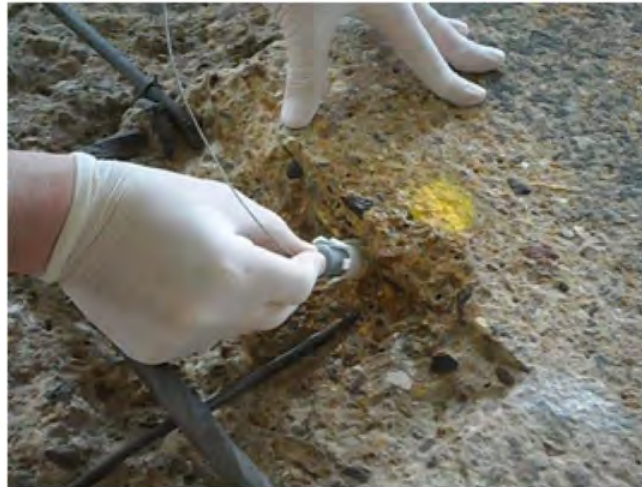
2. Insert the anode
